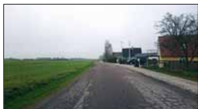
Asfalten ud ad Amdrupvej mod den gamle forsøgs- station
