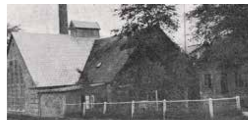
Mejeriet efter ombygningen.
