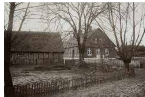
Billede af de gamle længer med bindingsværk som blev ombygget i 1960. Billedet er fra HØST juni 2014.
