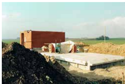
Her ses den underjordiske rentvandstank, ved Mejlbyvej 21, og pumpehuset under opførelse. Tanken kan indeholde 125.000 L.
